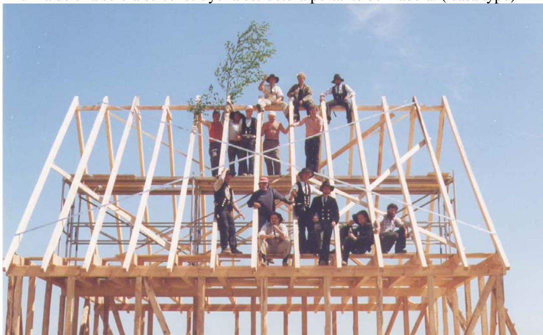
Encima de una solera se construye la estructura portante de madera. ( casa typo)
