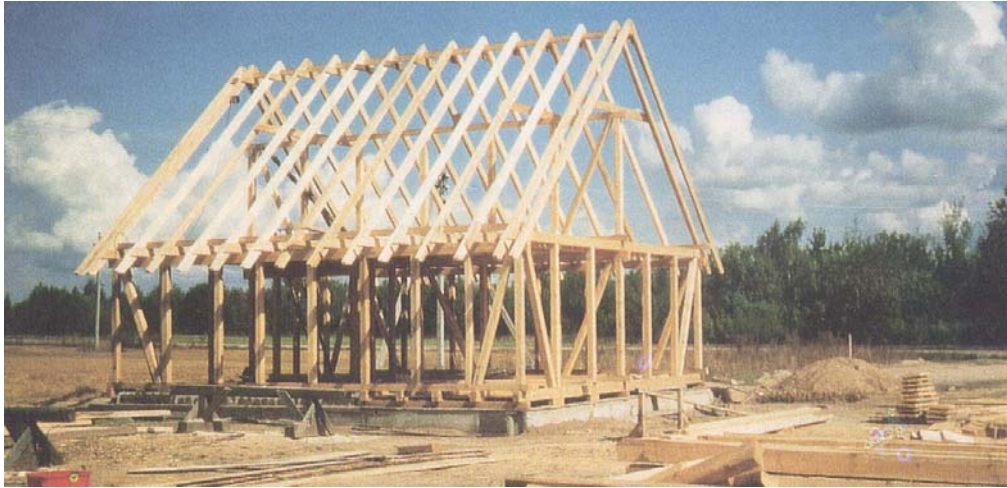
Encima de una solera se construye la estructura portante de madera. ( casa typo)
